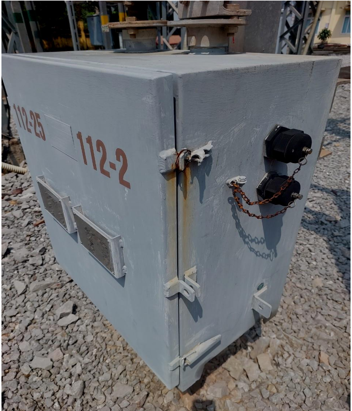
Vỏ tủ điều khiển DCL bị han rỉ, khóa tủ bị hỏng. Đơn vị đã nhiều lần sơn lại bề mặt ngoài vỏ tủ DCL
