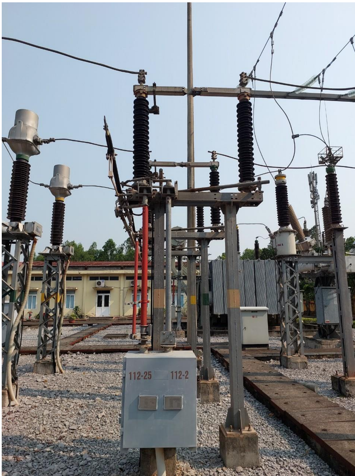
Hình ảnh DCL 3 pha, 1 nối đất tại TBA 110kV Tỉnh Gia
