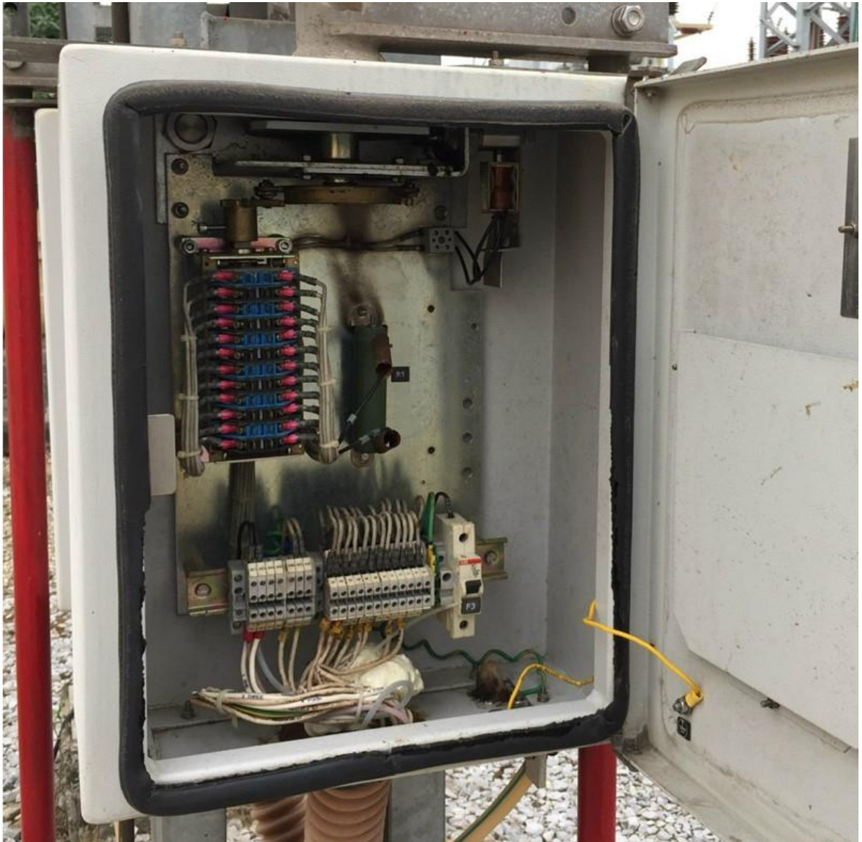
Hệ thống sấy trong tủ truyền động DCL hư hỏng.
