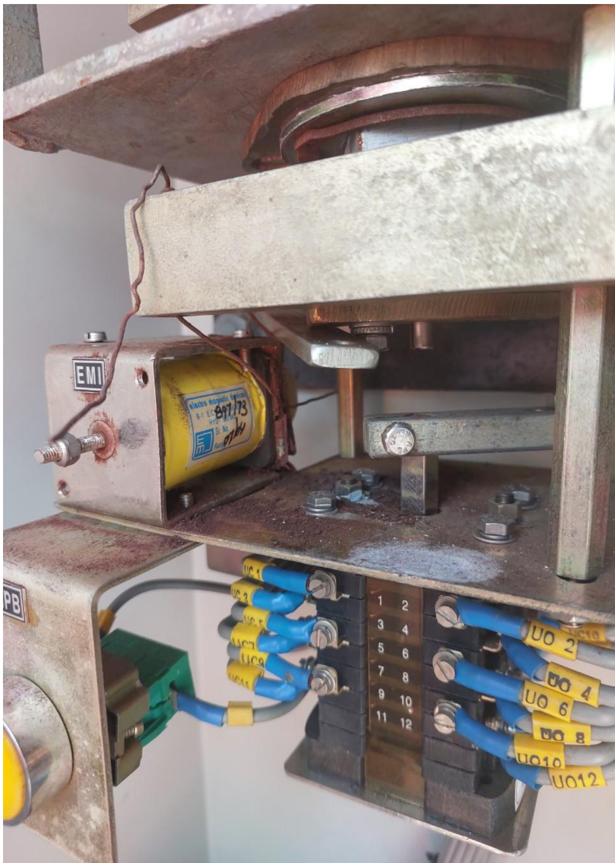
Hình ảnh cuộn hút chốt an toàn chống thao tác DTD trong tủ điều khiển tại chỗ DCL bị hư hỏng
