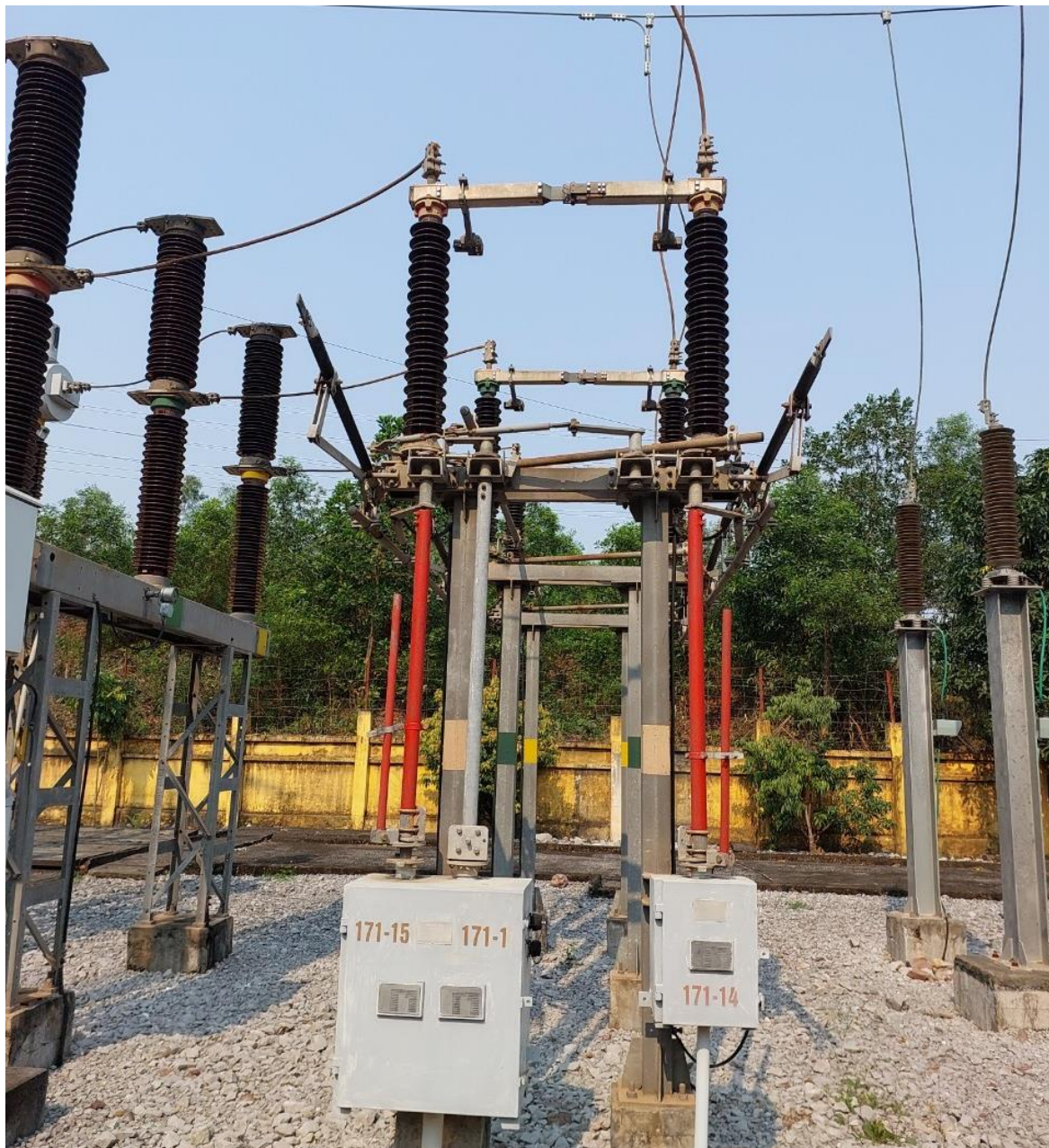
Hình ảnh DCL 3 pha, 2 nối đất tại TBA 110kV Tinh Gia
